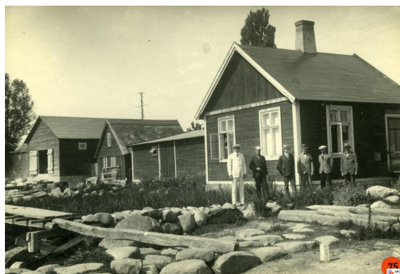
Hamnkontoret under byggtiden
