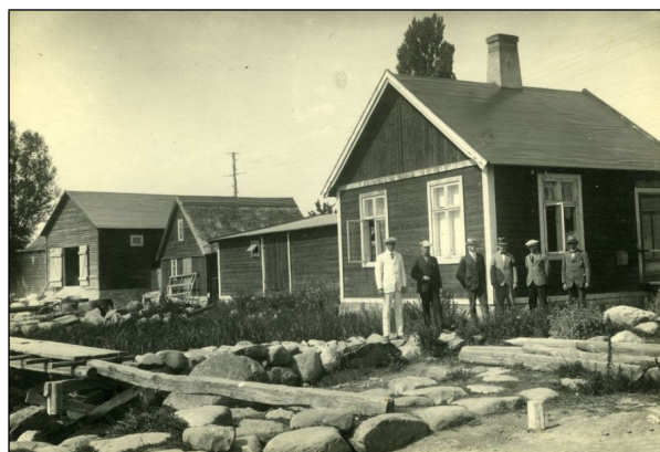
Hamnkontoret under byggtiden.
