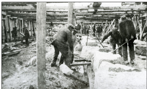
Pirhuvudet har påbörjats.
