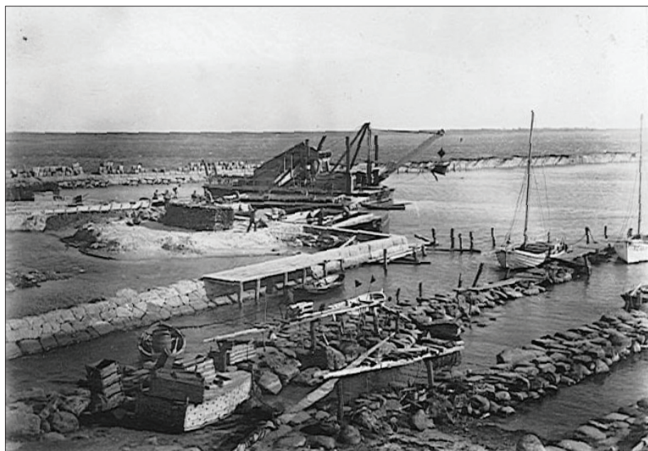
Vy mot sydost från Strandvägen 26. Kajen vid hamnplan är klar och nu börjar utfyllnad med det material som mudderverken tar upp. Foto från Riksarkivet.
