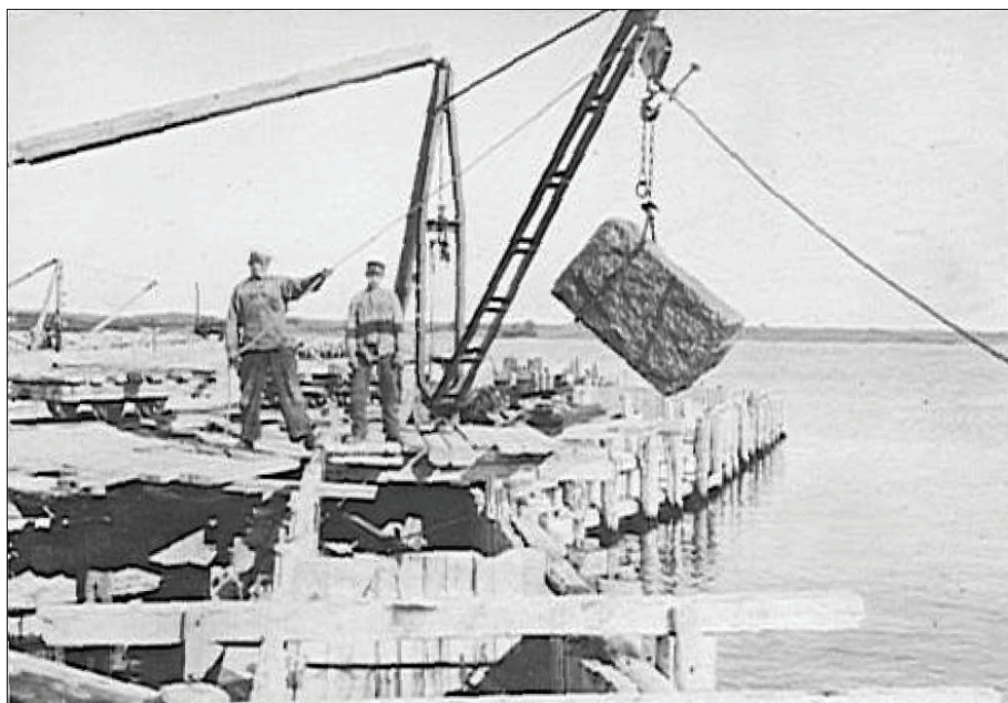
Den sten som utgjort brottskydd vid pirhuvudet plockas upp för att användas till den östra vågbrytaren. Foto från Riksarkivet.
